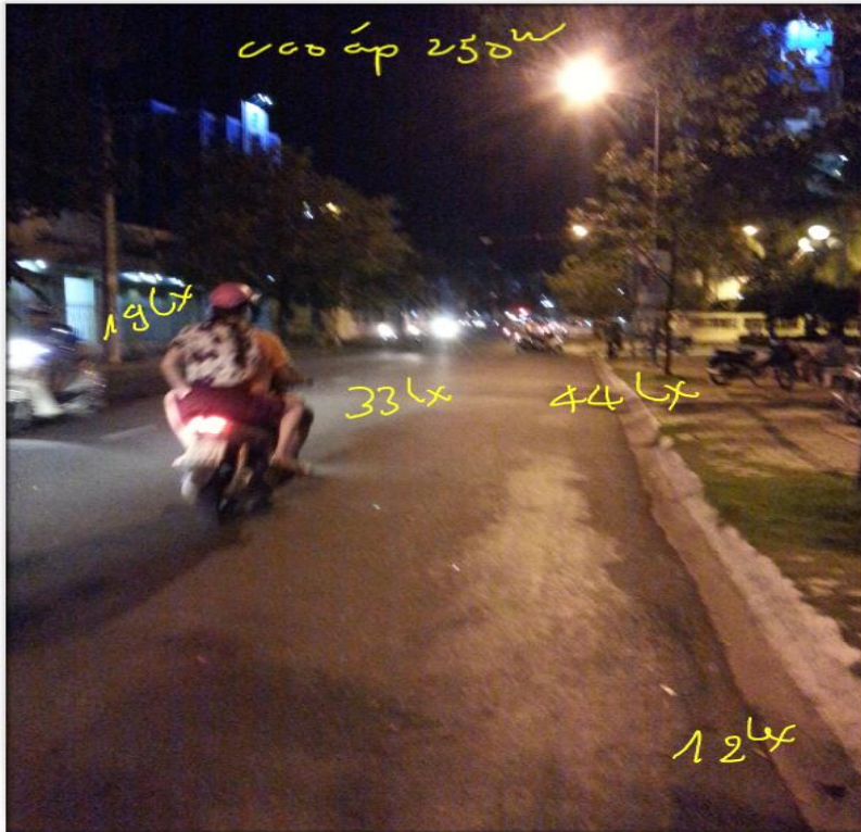
Hệ thống chiếu sáng cũ sử dụng đèn cao áp natri 250 W
