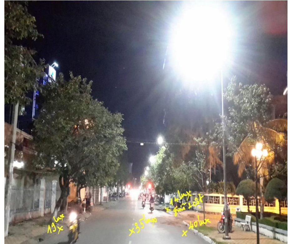
Hệ thống chiếu sáng mới Sử dụng đèn LED 120W tích hợp Diming của
